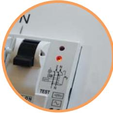
→ Обрыв нейтрального проводника (N). Устройство срабатывает. После восстановления нейтрального проводника (N) светодиод гаснет.
