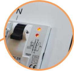
→ Обрыв заземляющего проводника (PE) или неправильное подключение фазного (L) и нейтрального (N) проводника. Устройство срабатывает.
