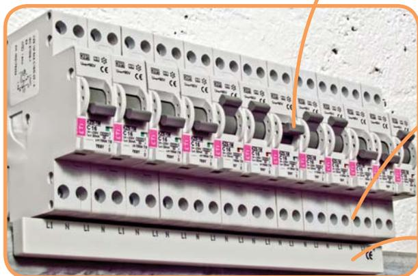
\* Среднее положение рукоятки занимает в том случае, если отключение произошло автоматически от срабатывания расцепителей. Для восстановления включенного положения устройства после автоматического отключения необходимо рукоятку опустить в нижнее положение («отключено»), ввести в зацепление механизм, а затем поднять рукоятку до крайнего верхнего положения.
