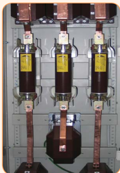
Внутренняя установка предохранителей
