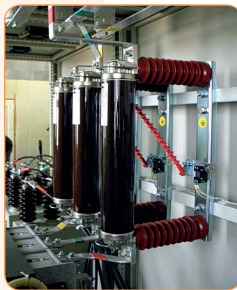
Установка внутренних держателей предохранителей*
